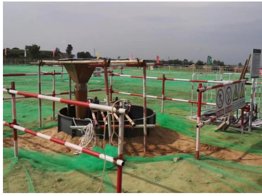
N0439 塔基区临时苫盖
