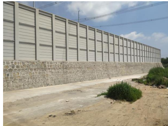
秦道开关站站区浆砌石护坡
