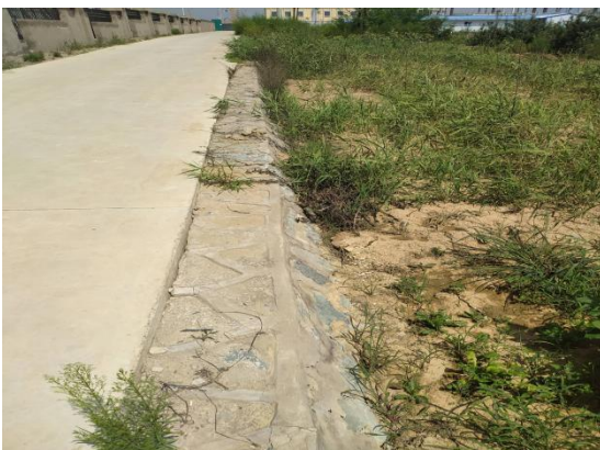
秦道开关站进站道路及护坡
