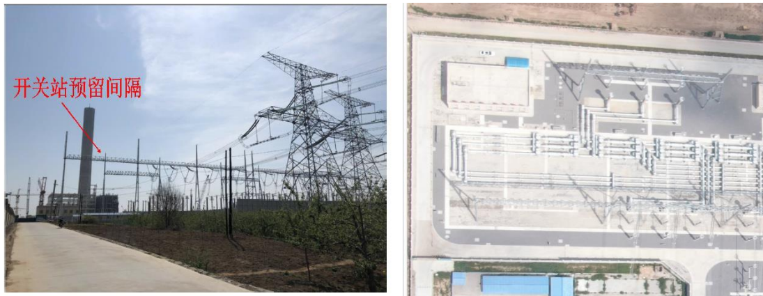
本期扩建场地及站区现状
