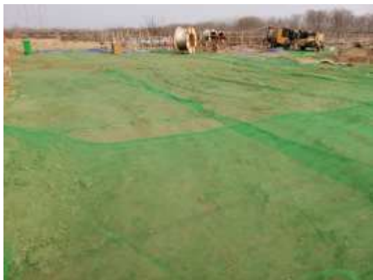
临时措施现场监测
