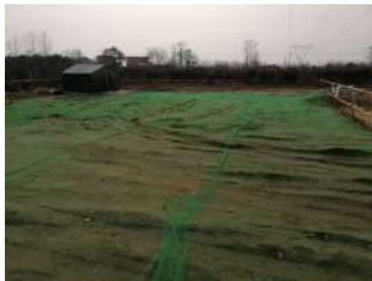
临时措施现场监测
