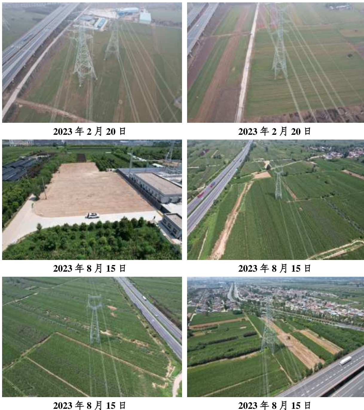
图 2-1 工程措施现场调查监测照片
