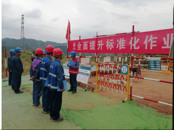
施工场地密网遮盖
