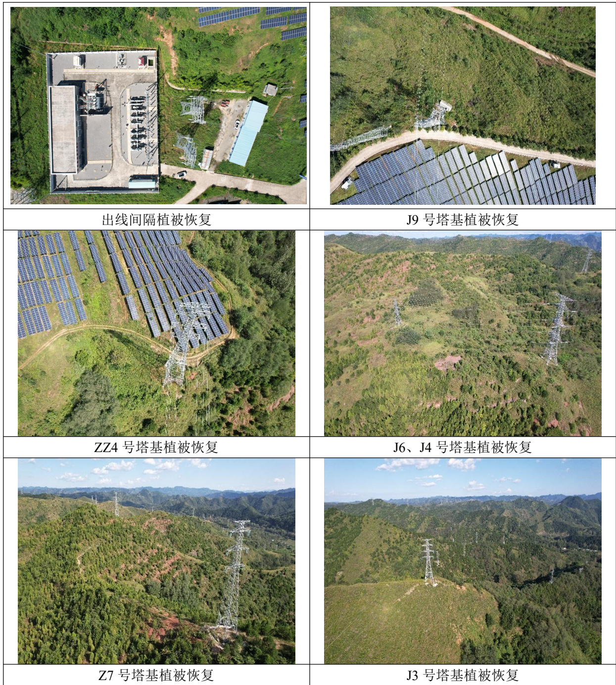
图 6-1 商洛保安~商县改接入荆河变 110kV 线路工程现场照片
