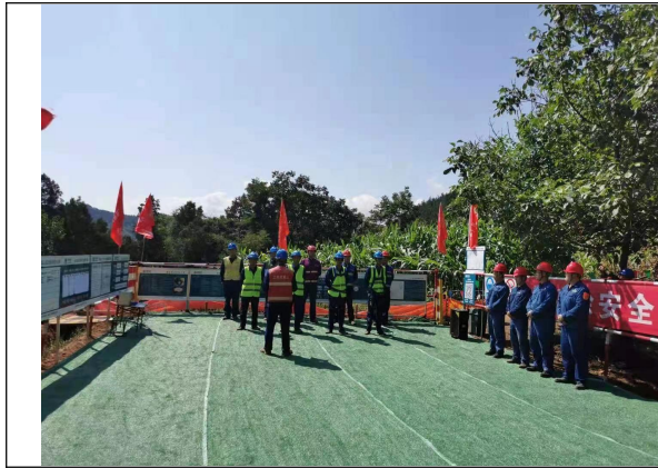
施工场地苫盖
