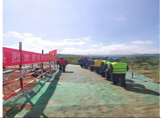
施工场地密网遮盖
