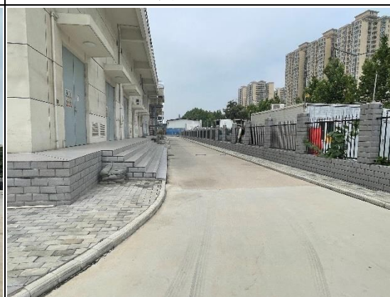
站内道路硬化
