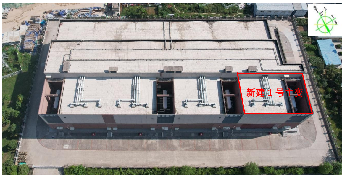
图 3.2-2 玄武 330kV 变电站航拍图
