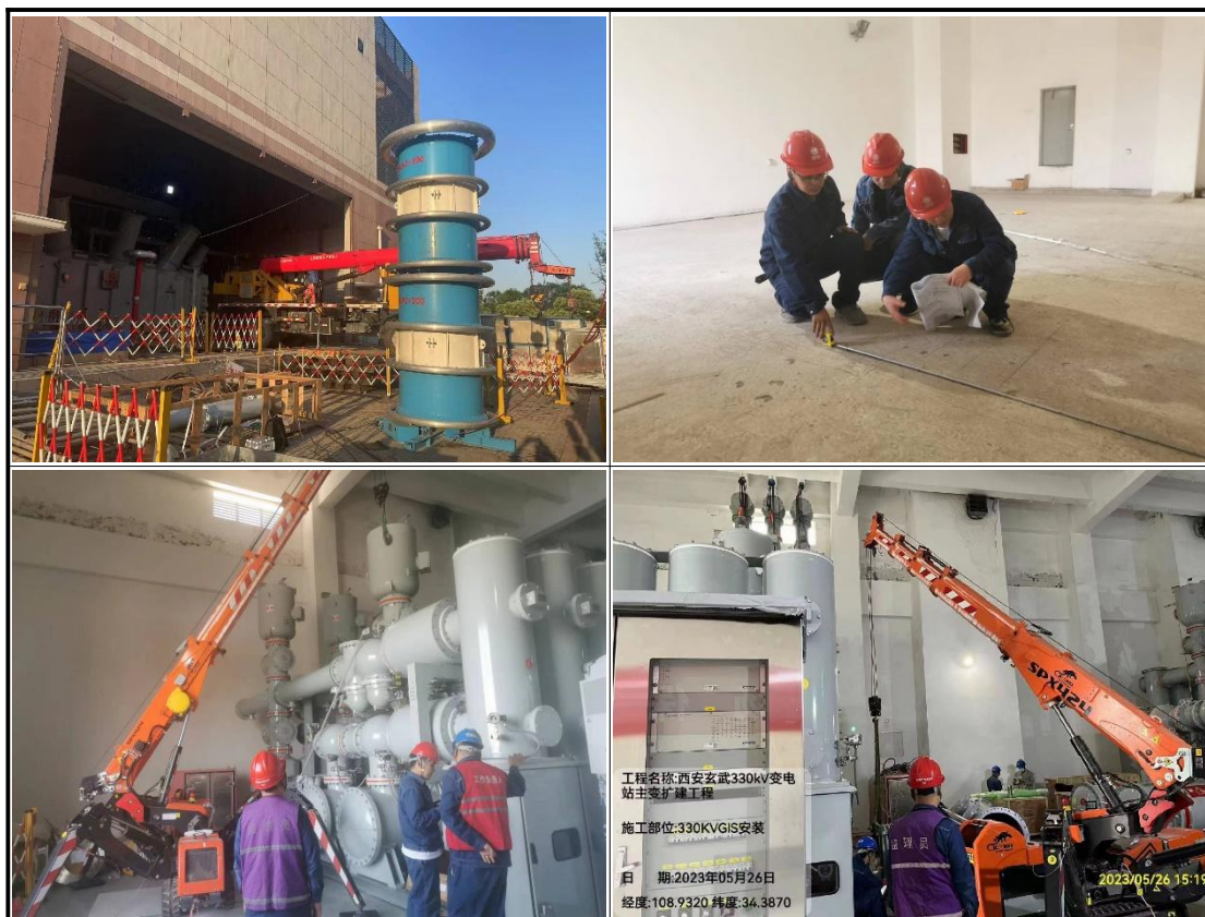
图 5.3-2 本工程施工照片
