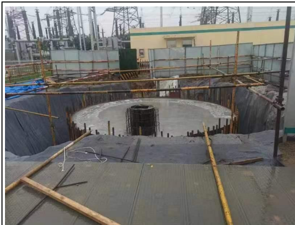
新建事故油池基础开挖
