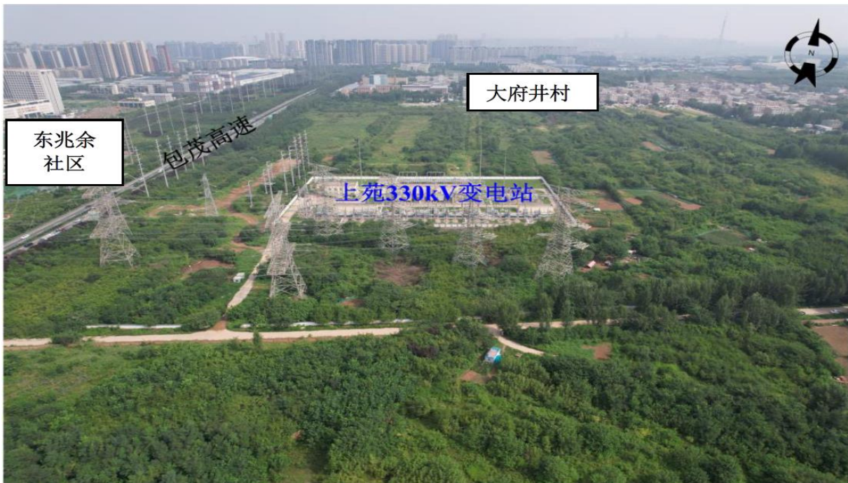
图 4-2 上苑 330kV 变电站现状图
