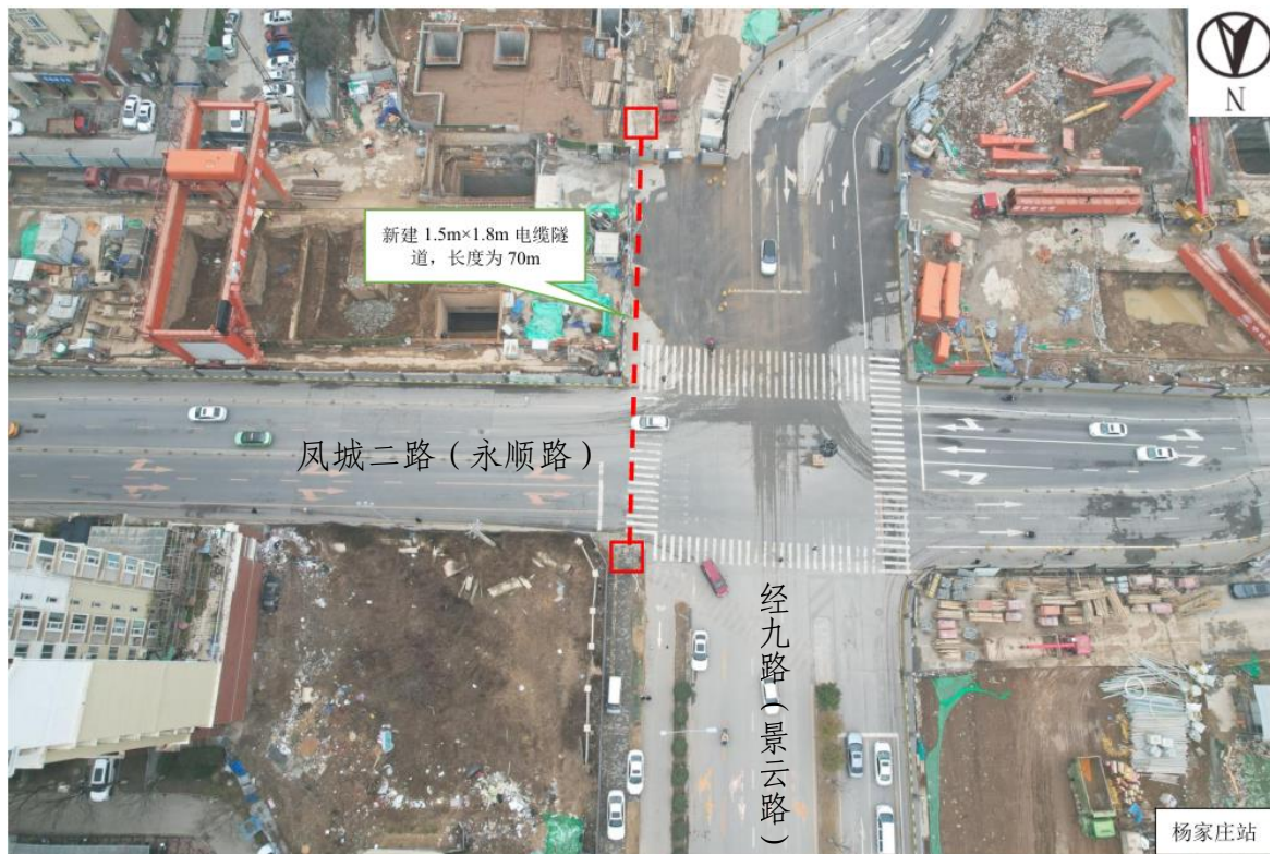
杨家庄地铁站预留通道
