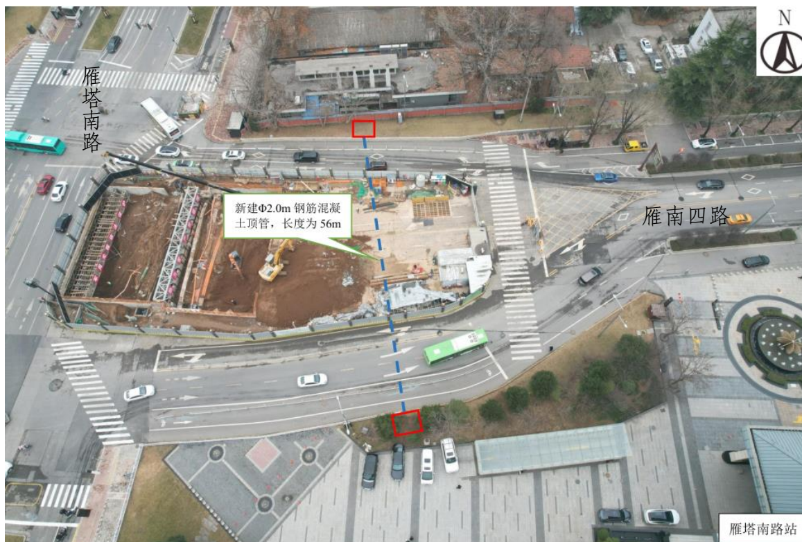
雁塔南路地铁站预留通道
