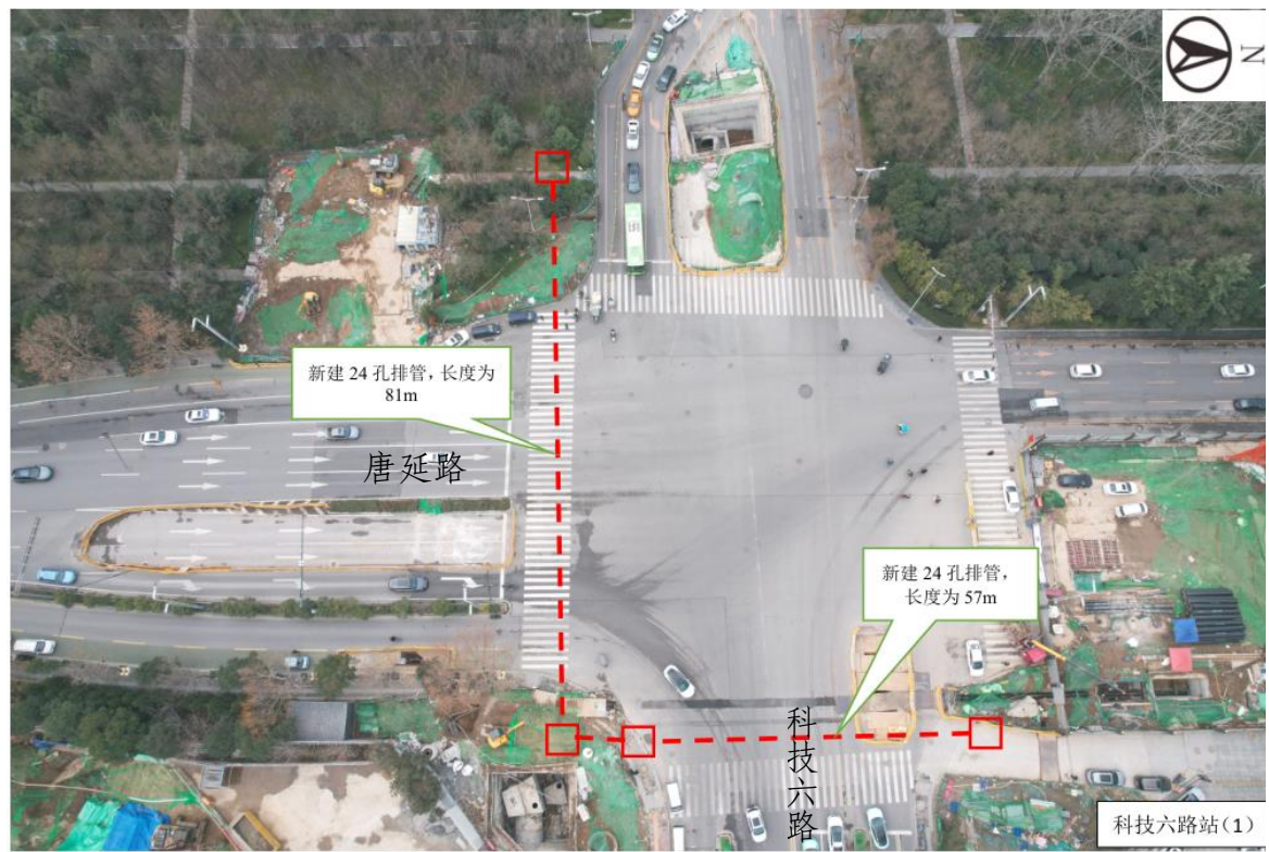
科技六路地铁站预留通道
