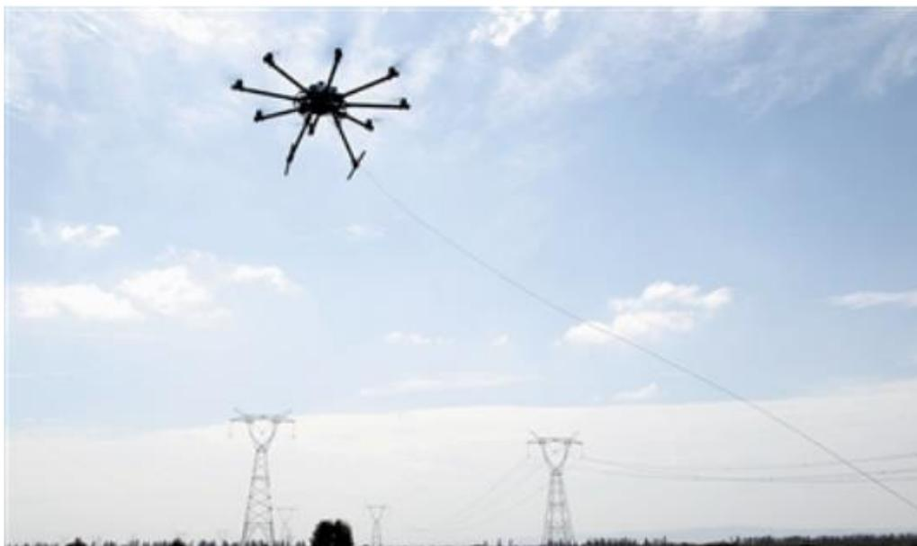
图 2.4-4 八旋翼飞行器展放导引线
