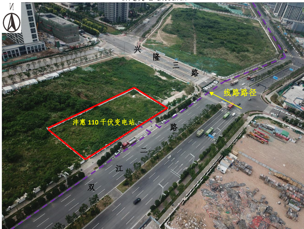
项目总体布置现状照片
