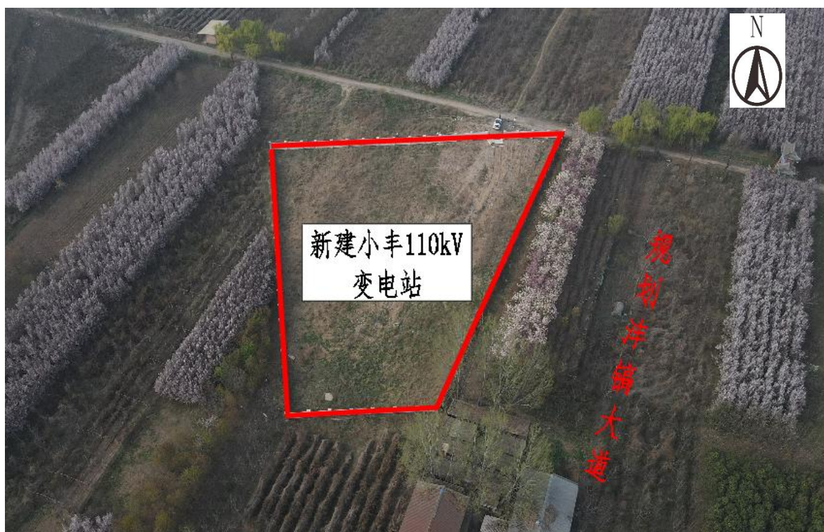
新建小丰 110kV 变电站站址
