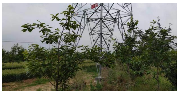
庄牵线塔基恢复情况
