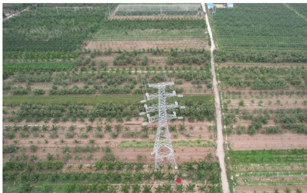
T 接处（拆除原耀庄线 17 号塔基恢复情况）
