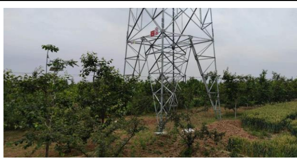
庄牵线塔基恢复情况
