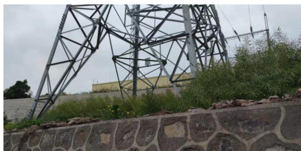
庄牵线塔基恢复情况
