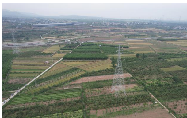
牵庄、牵耀 T 线塔基恢复情况
