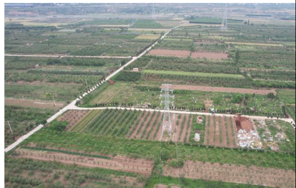
牵庄、牵耀 T 线塔基恢复情况
