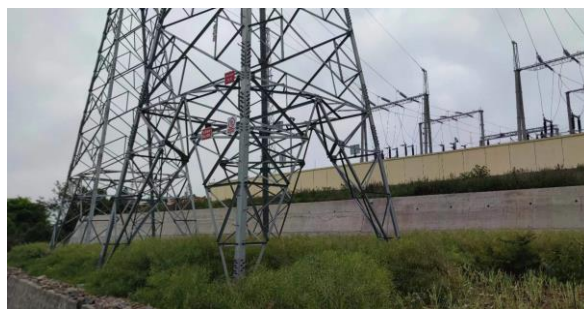
庄牵线塔基恢复情况
