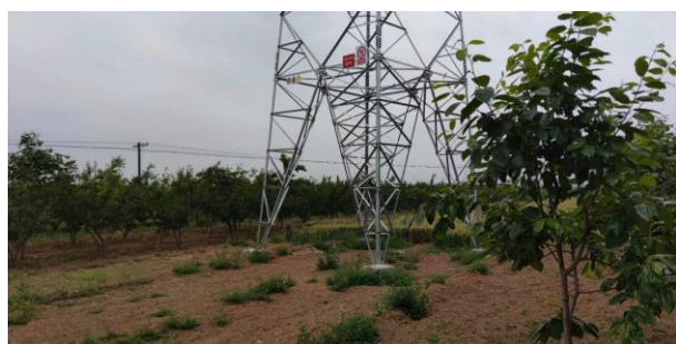
庄牵线塔基恢复情况
