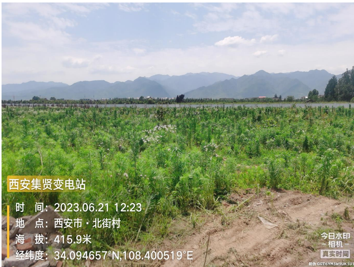
集贤变电站现状照片
