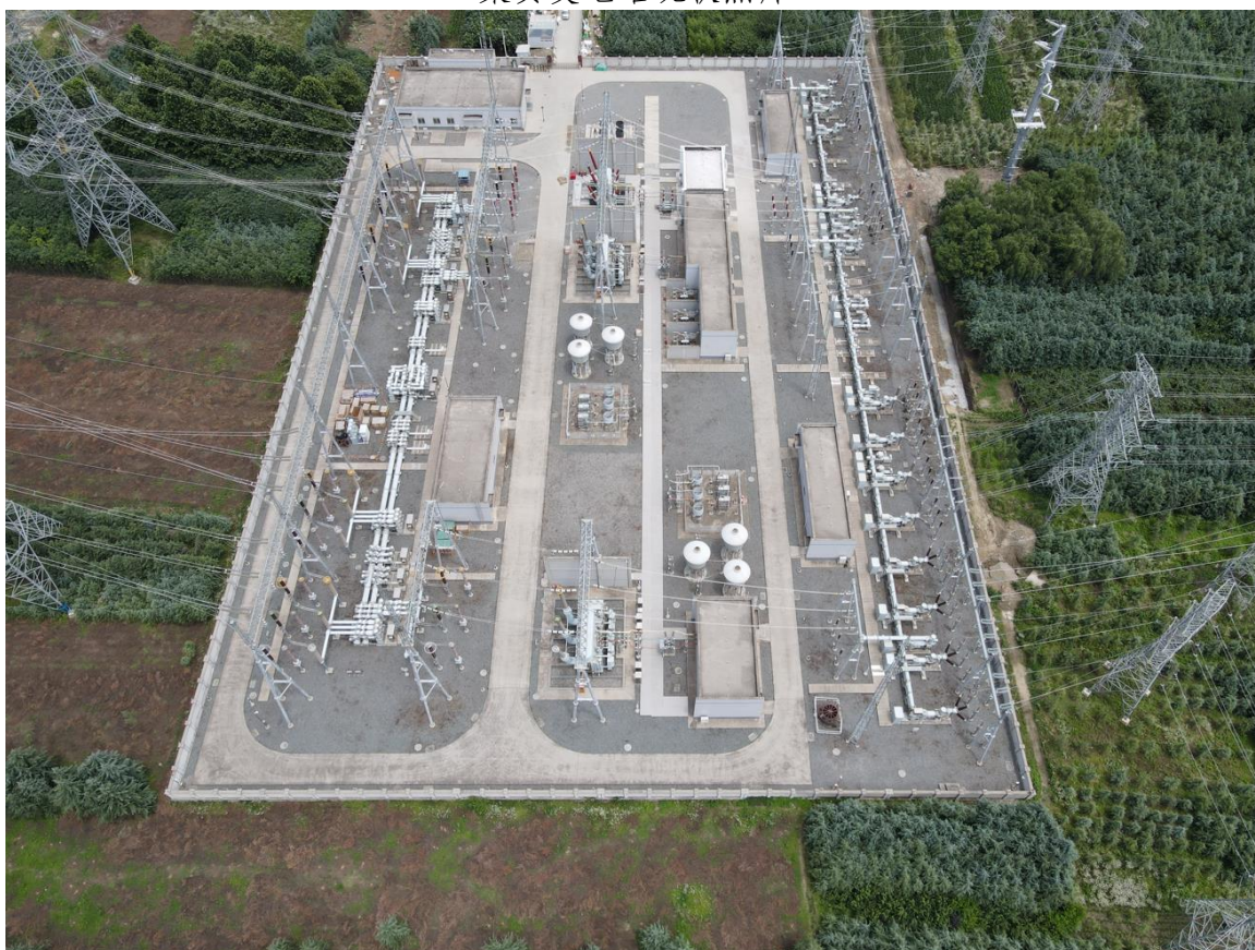
在建古路 330 千伏变电站现状照片
