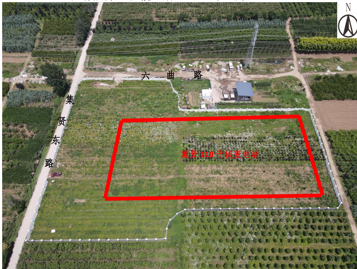
新建变电站航拍图
