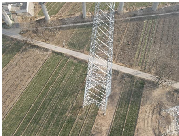
Z5 塔基及施工场地复耕 (2022 年 7 月)
