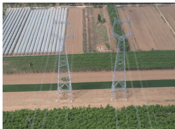
ZR13 和 ZL13 塔基及施工场地复耕 (2022 年 7 月)
