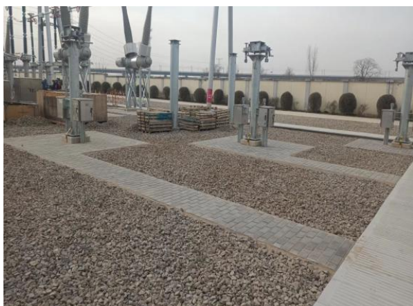
信义 750kV 变电站扩建间隔 (2022 年 3 月)
