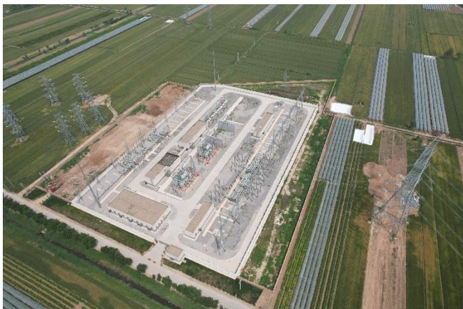
渭南北 330kV 变电站 (2023 年 5 月)
