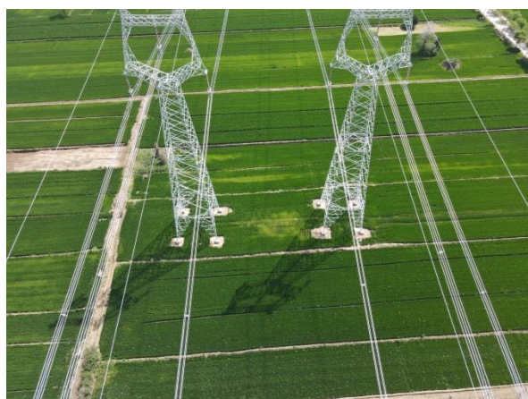
ZR14 和 ZL14 塔基及施工场地复耕 (2022 年 7 月)
