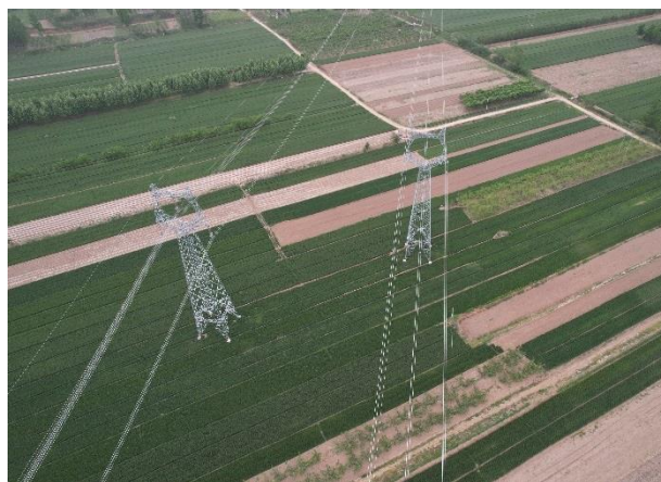
ZRA8 和 ZLA8 塔基及施工场地复耕 (2022 年 7 月)
