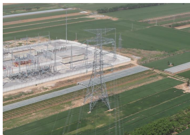
J16 塔基及施工场地复耕 (2022 年 7 月)
