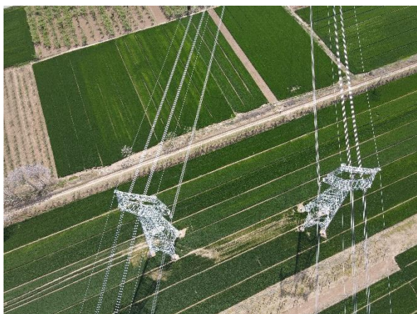
ZRA7 和 ZLA7 塔基及施工场地复耕 (2022 年 7 月)
