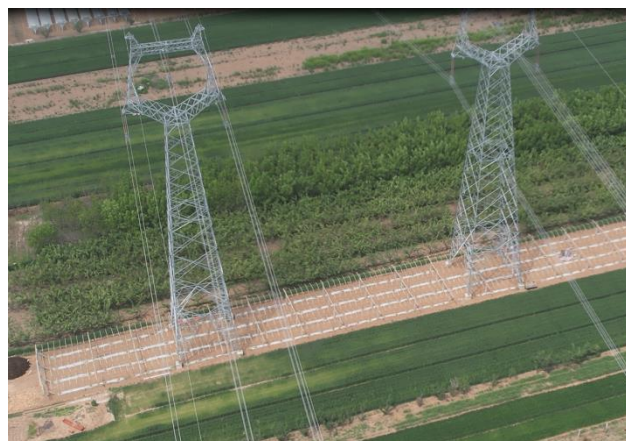
ZR11 和 ZL11 塔基及施工场地复耕 (2022 年 7 月)
