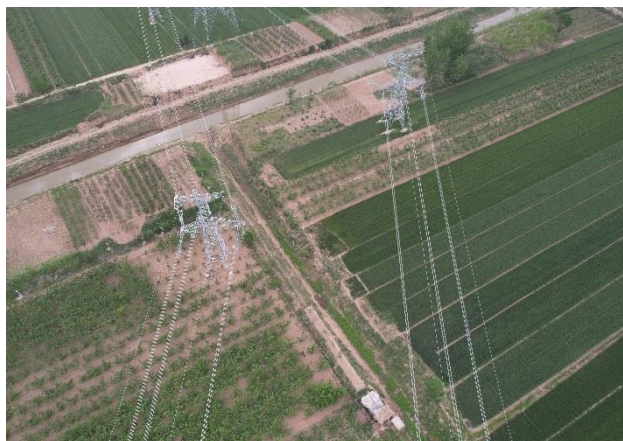
JRA9 和 JLA9 塔基及施工场地复耕 (2022 年 7 月)
