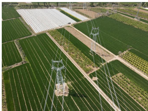
ZL3 和 ZR3 塔基及施工场地复耕 (2022 年 7 月)
