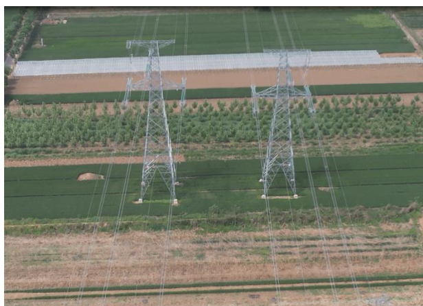
JR12 和 JL12 塔基及施工场地复耕 (2022 年 7 月)
