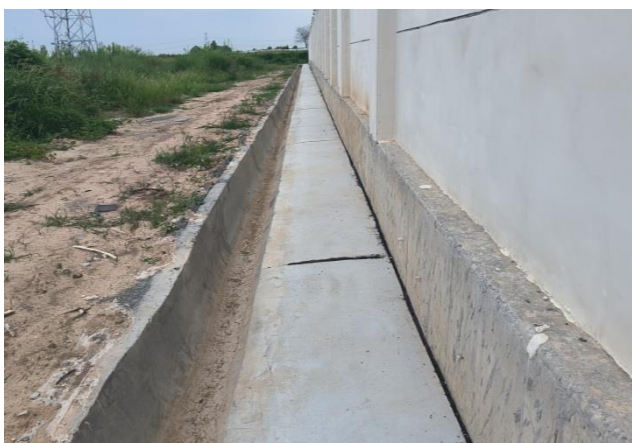
渭南北 330kV 变电站站外排水沟 (2022 年 6 月)
