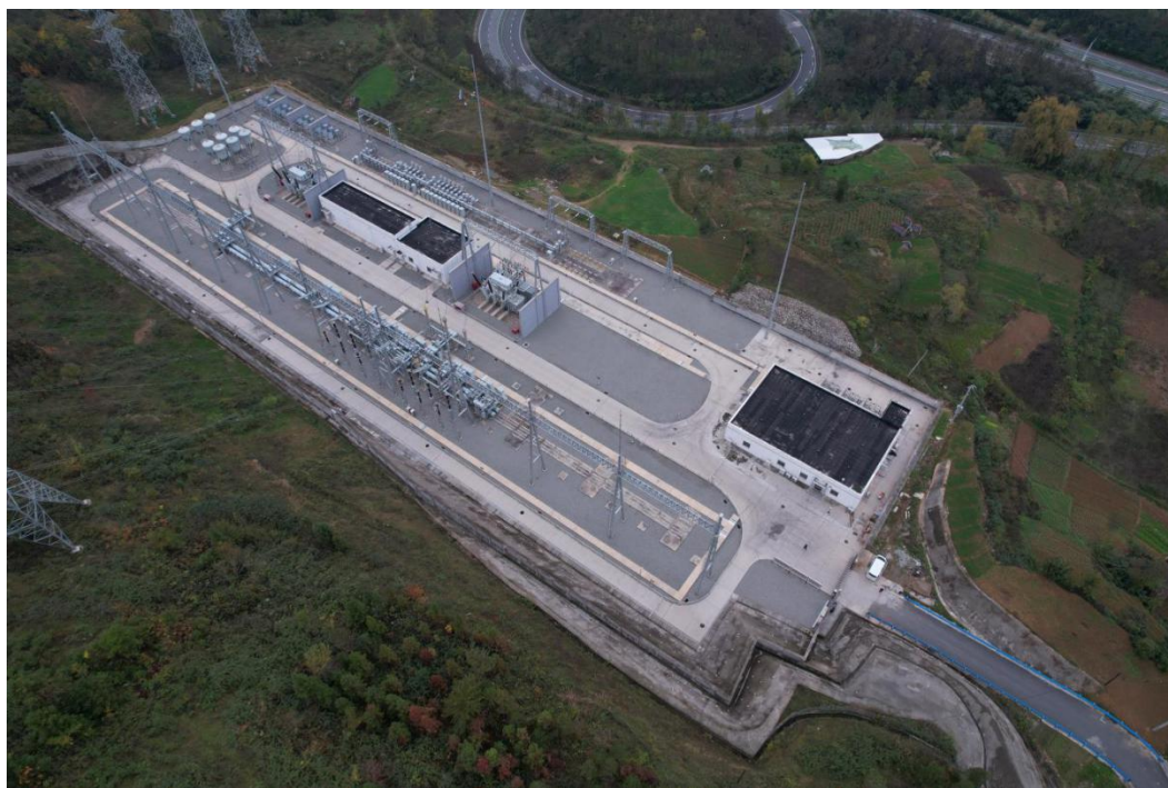
图 4.2-1 月河 330kV 变电站周围现状
