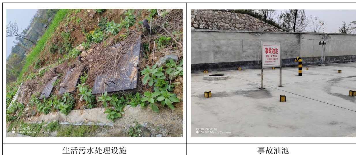
图 3.2-1 月河 330kV 变电站环保设施现状照片
