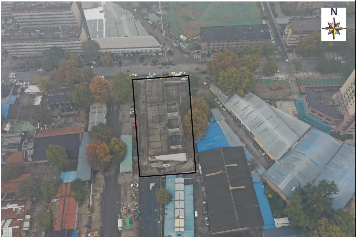
图4-4 110kV桃园路变电站现状航拍图
