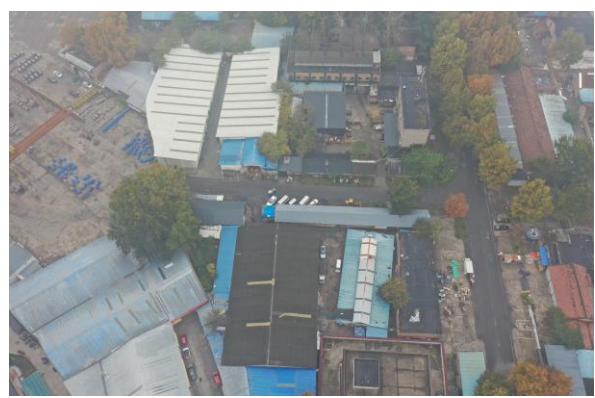
110kV 桃园路变电站南侧环境
