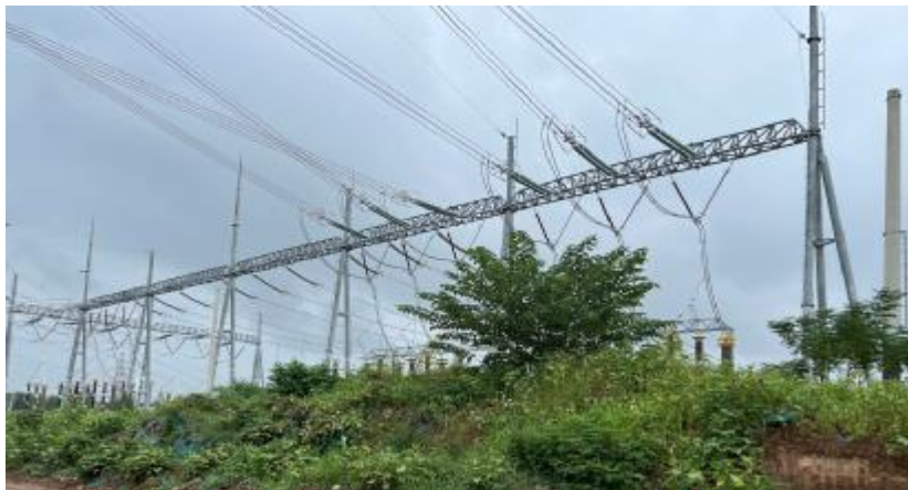
训善330kV变电站站址扩建区
