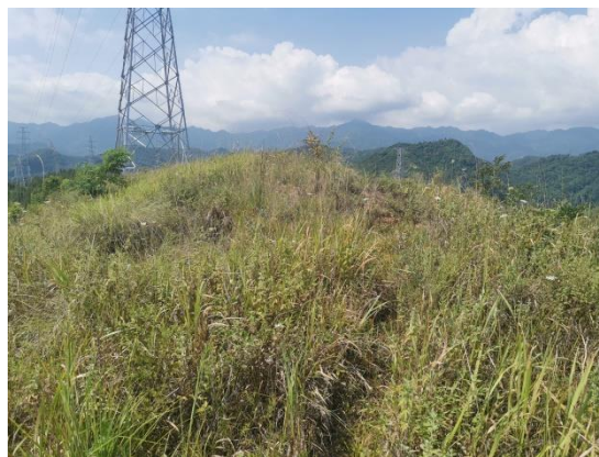
施工便道绿化
