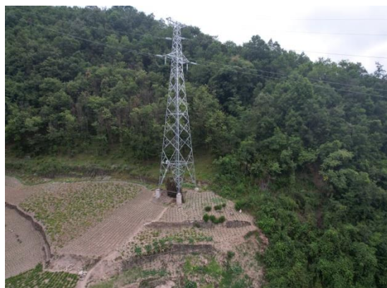
塔基施工场地复耕
