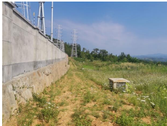
电缆施工场地土地整治
