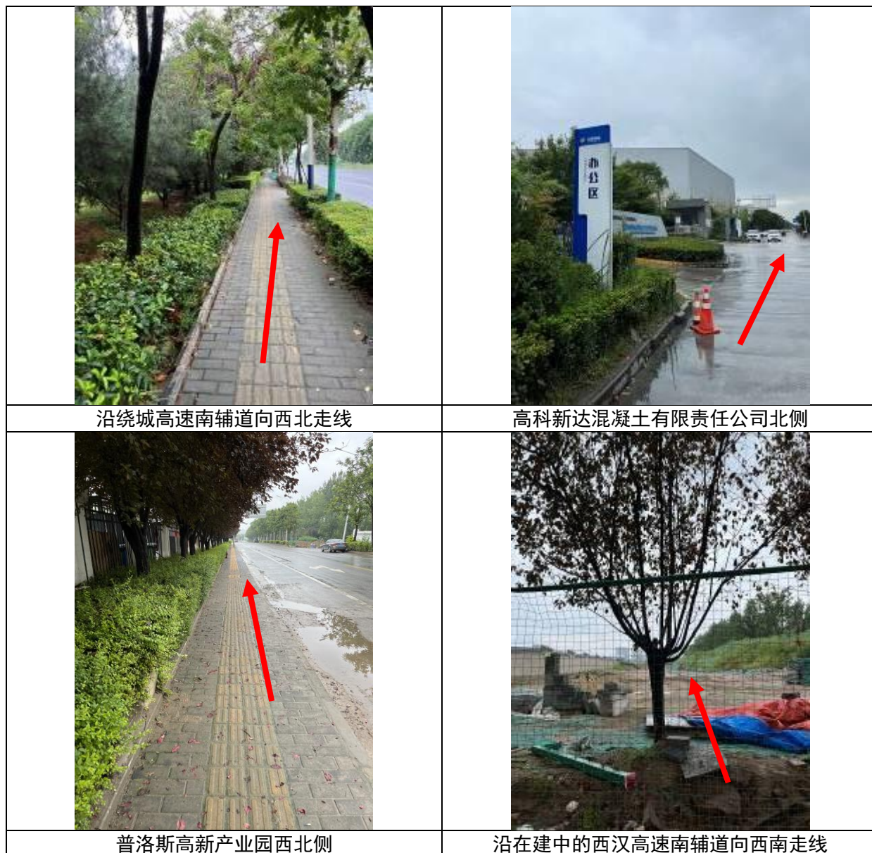
图 3.1-16 新建万达变~训善变 330kV 电缆线路沿线现状照片（部分）
