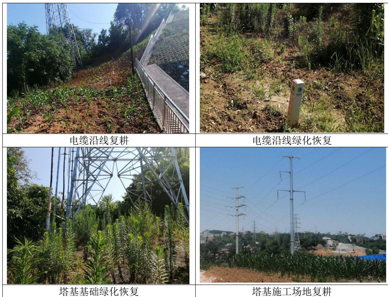
图 8-1 本项目沿线植被恢复照片
