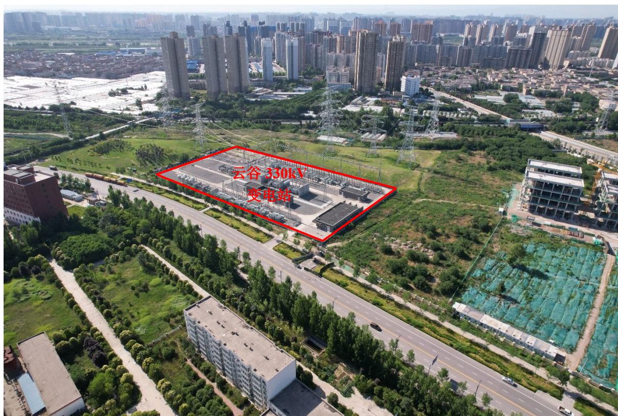
图 4.5-1 云谷 330kV 变电站周边生态环境现状照片
