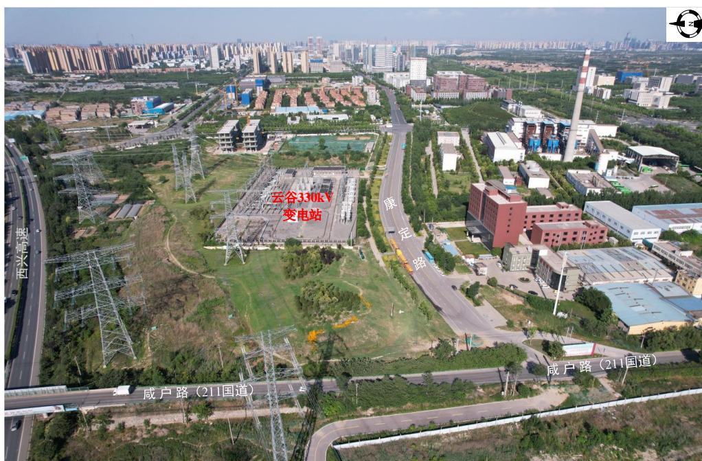
图 4.2-1 云谷 330kV 变电站周围现状
