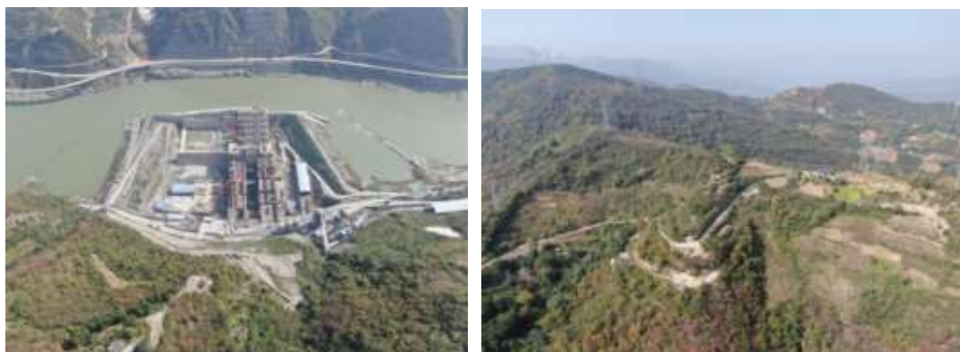
输电线路工程原地貌
