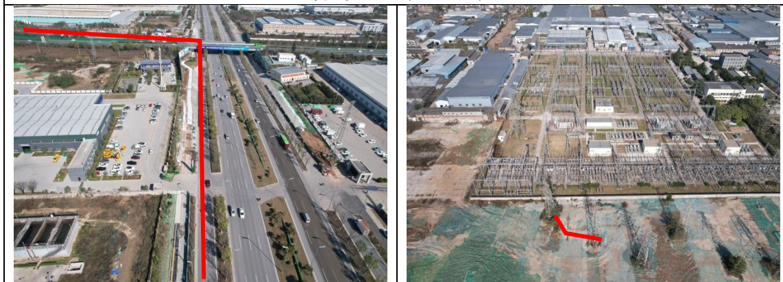
电缆走向（丰镐大道）
