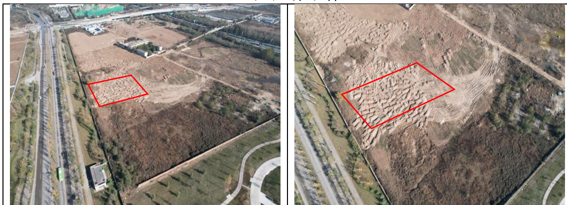
拟建 110kV 变电站站址现状
