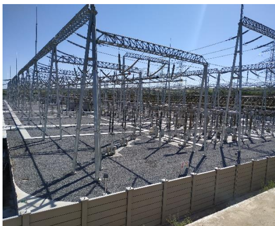
站区碎石覆盖
