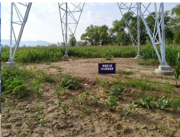
塔基及施工场地复耕
