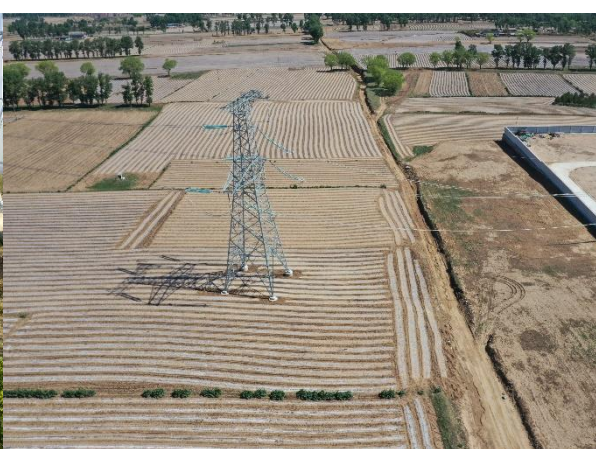
施工便道复耕
