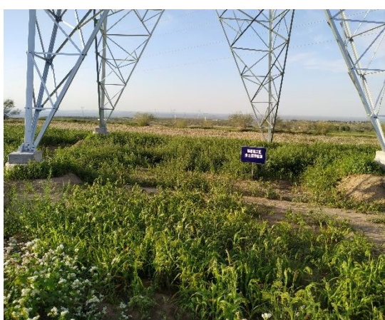
塔基及施工场地复耕
