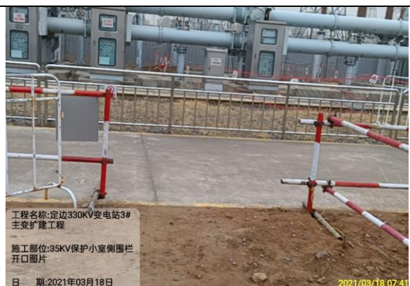
施工区与非施工区用硬质围挡隔离
