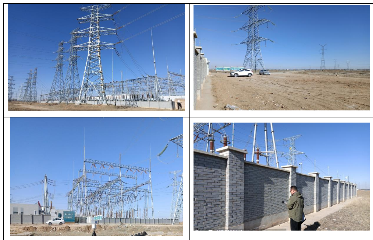
图 4-2 变电站四周情况现状照片
