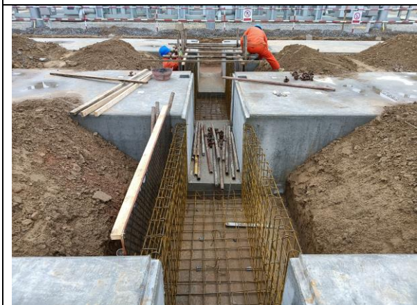
施工材料集中堆放；黏土、沙土分开堆放；洒水扬尘、保持土地湿润
