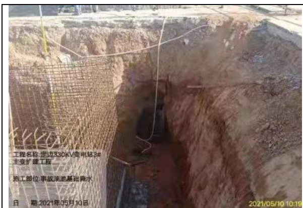
新建事故油池（30m 3 ）施工期照片
