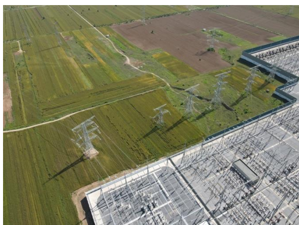
塔基区土地复耕
