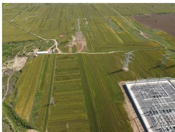
塔基区土地复耕
