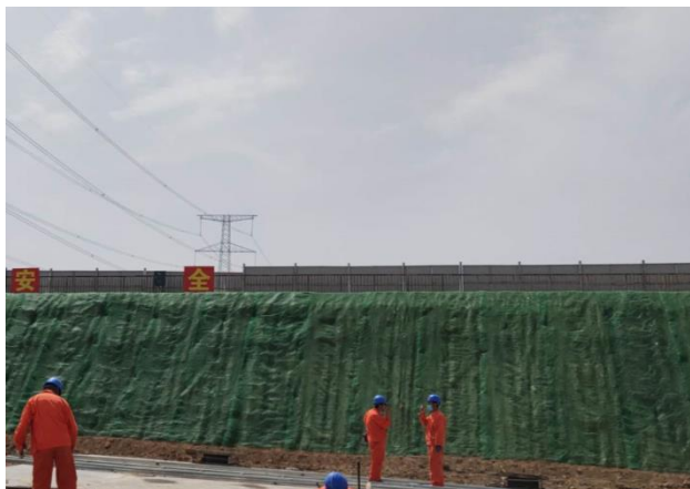
站区护坡临时苫盖
