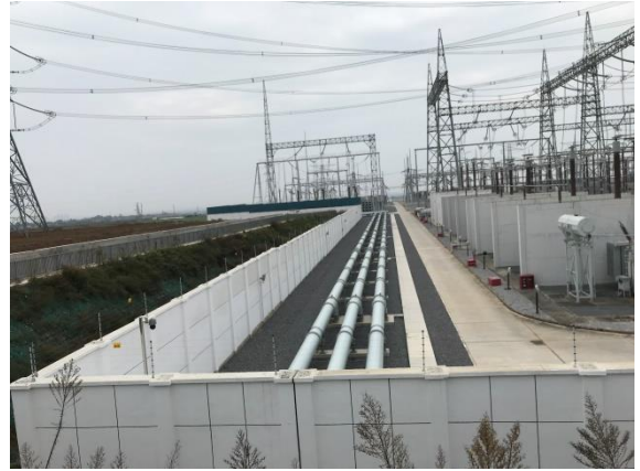
东侧地块碎石铺盖 (2021年10月)
