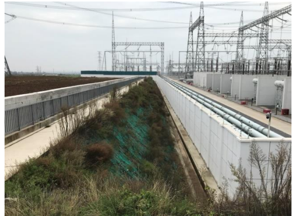
边坡绿化及坡脚排水沟 (2021年10月)
