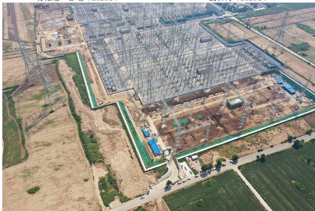
项目建设情况 (2020.8)
