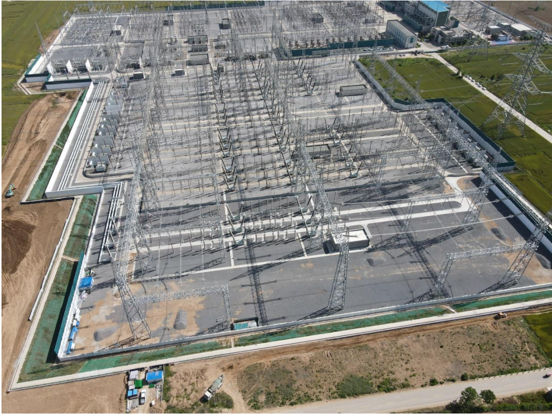
建设地块碎石铺盖、边坡绿化
