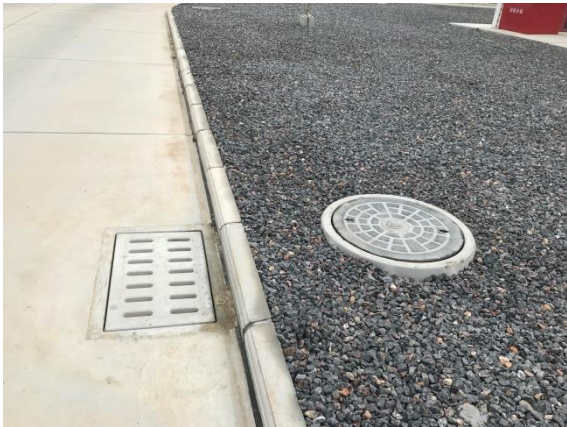
雨水井、雨水口 (2021年10月)
