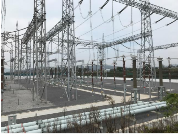
北侧地块碎石铺盖 (2021年10月)
