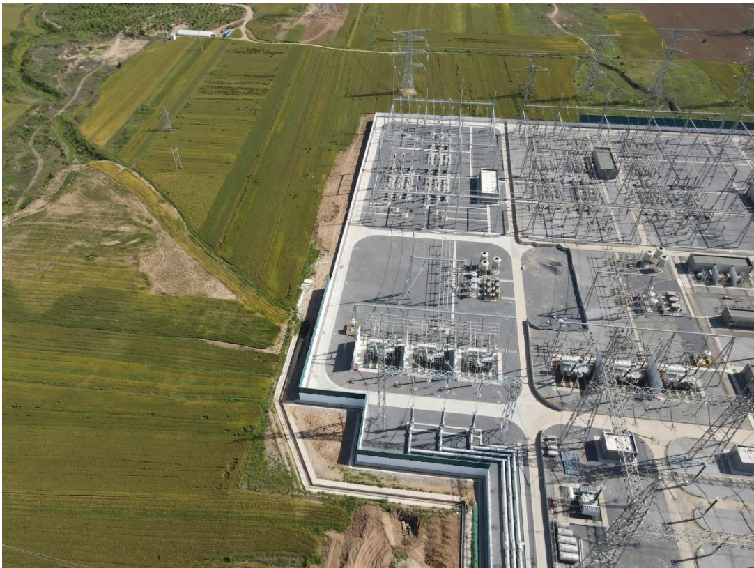
截洪沟、东侧余方综合利用场和塔基复耕（2021年5月）
