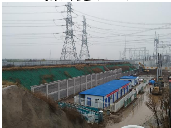
硬化施工营地 (2020.5)
