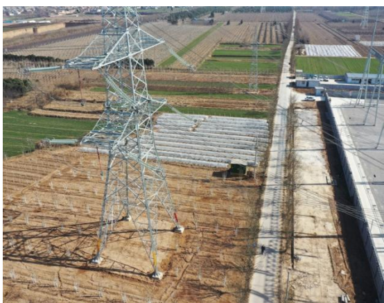
塔基及施工场地土地整治与复耕
