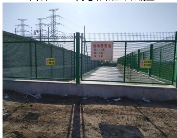
武镇 330kV 变电站站外雨水蒸发池
