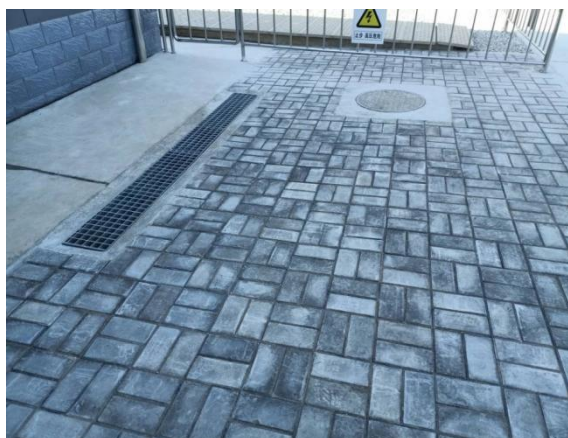
武镇 330kV 变电站站区透水砖地坪
