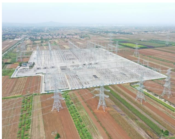
塔基及施工场地、施工便道复耕
