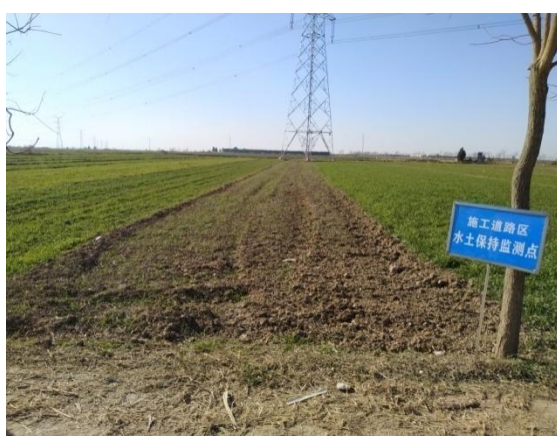
施工便道土地整治与复耕
