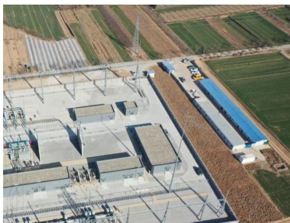
武镇 330kV 变电站施工生活区复耕
