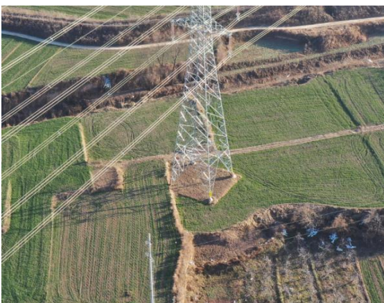
塔基永久占地土地整治
