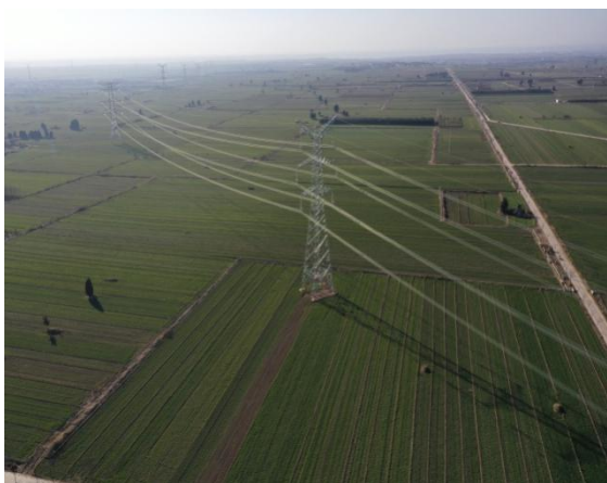
新建输电线路塔基及施工场地复耕
