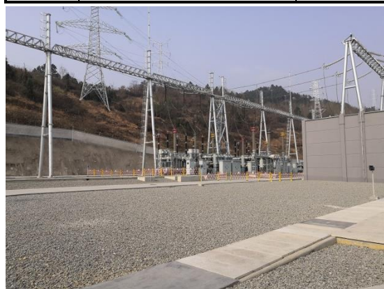
变电站碎石覆盖
