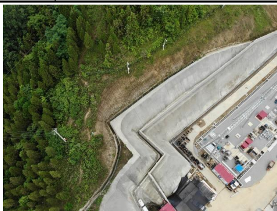
变电站排水工程
