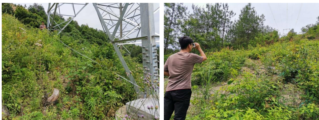
输电线路施工扰动面积实地测量
