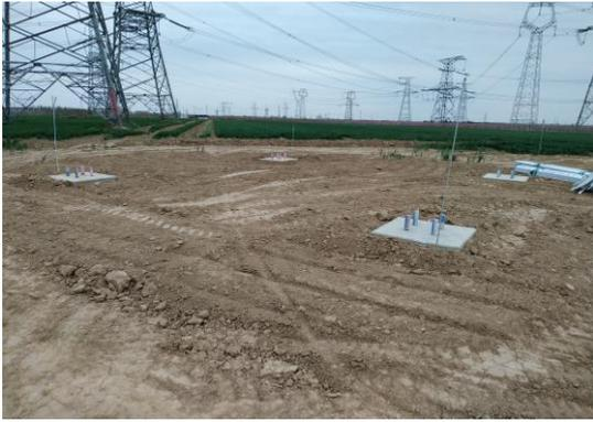
输电线路塔基基础浇筑完成
