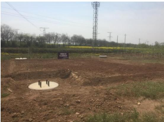
塔基基础浇筑完成
