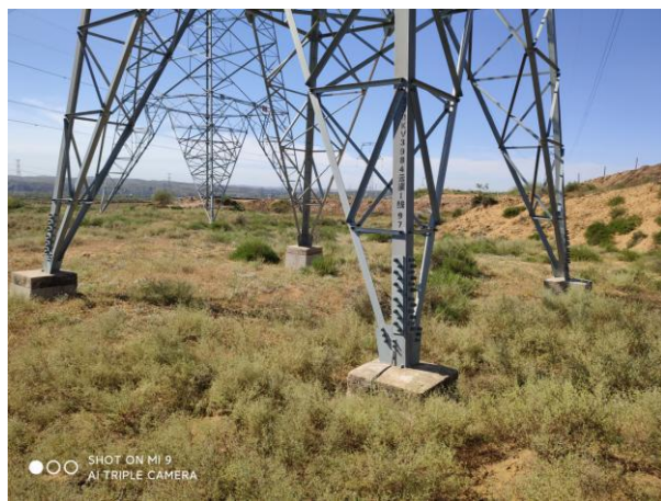
风沙区塔基绿化（云横 I 线 097）
