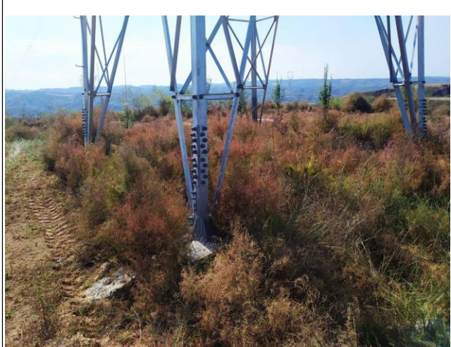
梁峁区塔基绿化 (云横 II 线 020)
