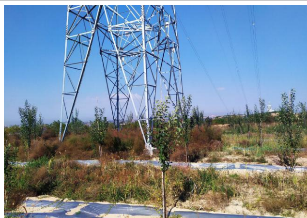
梁峁区塔基现状 (云横 II 线 018)
