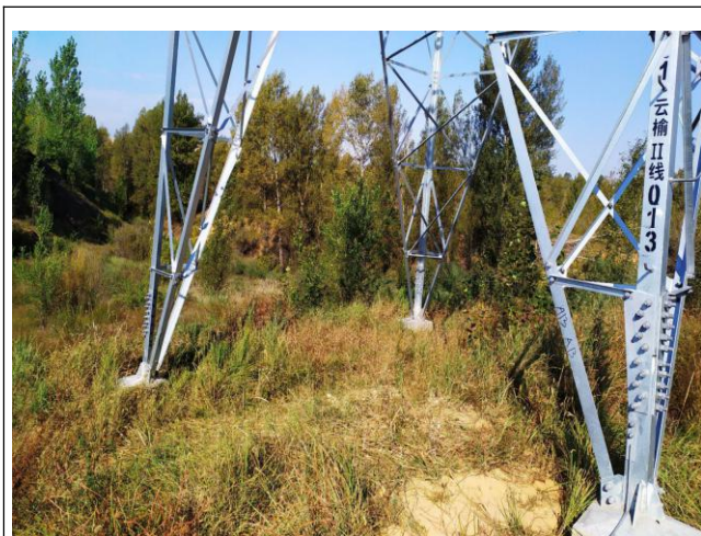
梁峁区塔基绿化 (云横 II 线 013)
