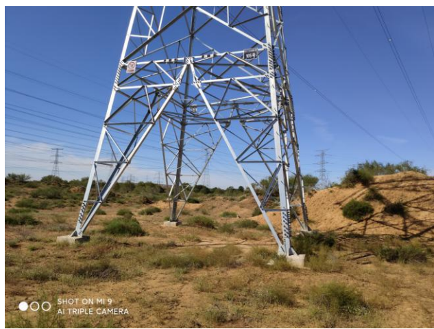
风沙区塔基绿化（云横 I 线 105）
