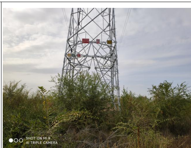
梁峁区塔基绿化 (云横 II 线 011)
