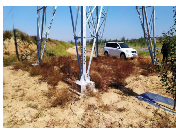
梁峁区塔基绿化 (云横 II 线 019)
