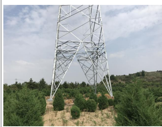
梁峁区塔基绿化 (云横 II 线 029)
