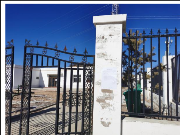
王台组大庆采油厂薛岔作业区宿舍
