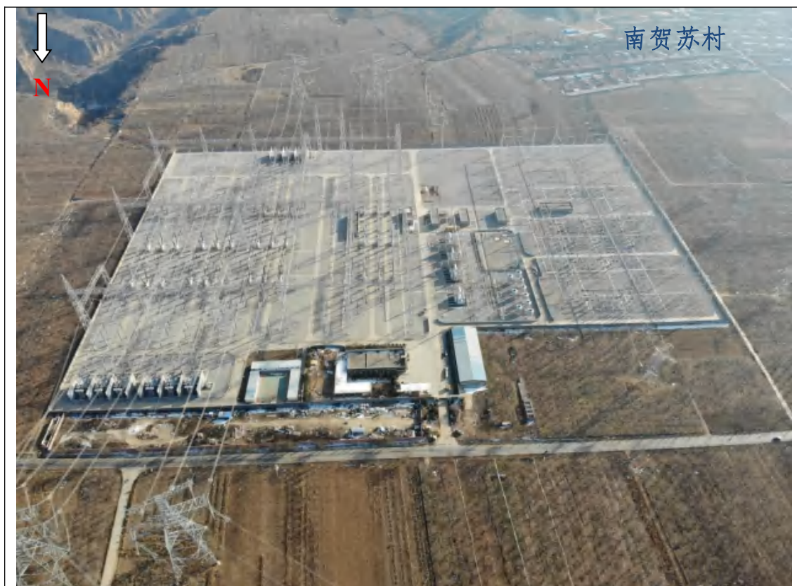
洛川750kV变电站俯视图
