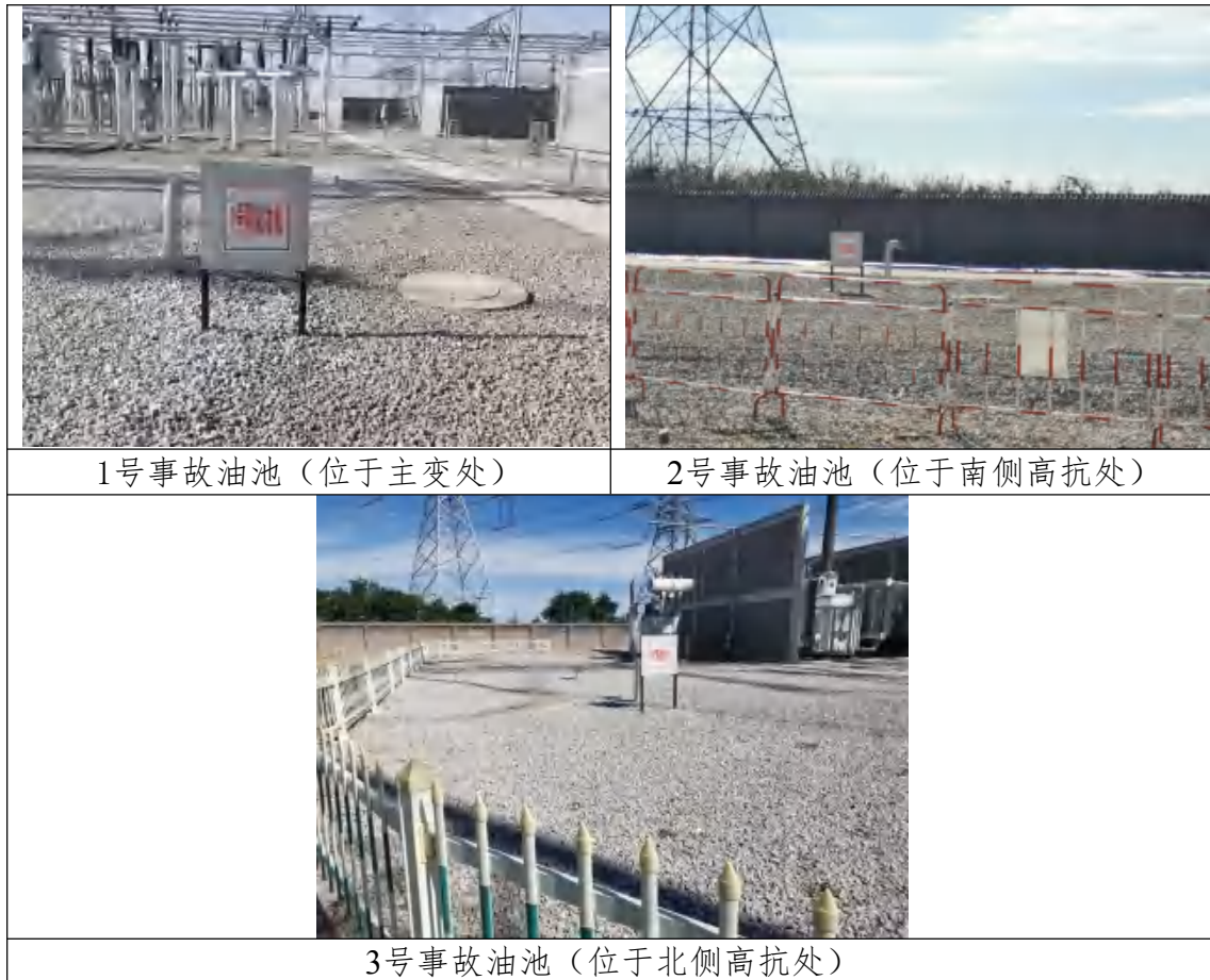
图3.23 洛川750kV变电站设置现有事故油池情况
