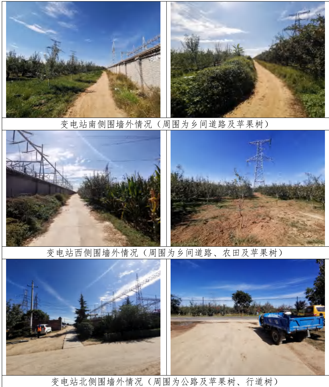
图3.2 洛川750kV变电站周围环境概况
