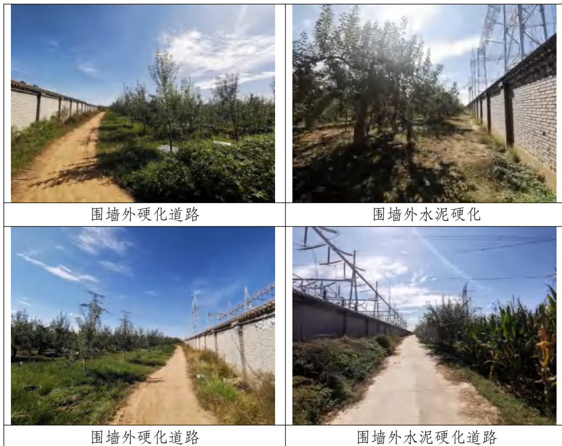
图3.27 洛川750kV变电站设置水土保持措施情况
