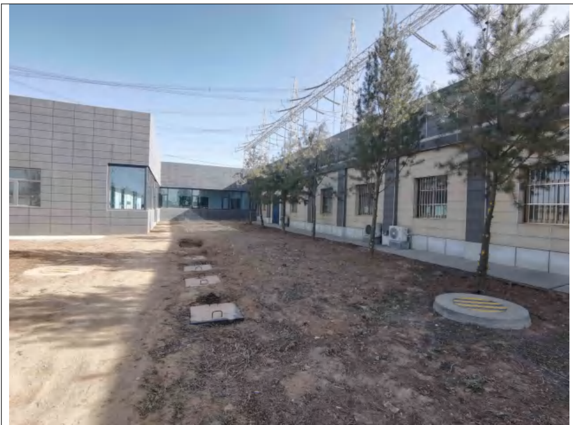
位于变电站主控楼北侧
