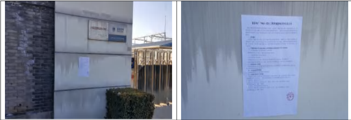
国网洛川750kV变电站
