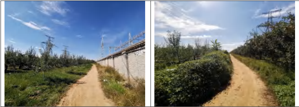
变电站南侧围墙外情况（周围为乡间道路及苹果树）
