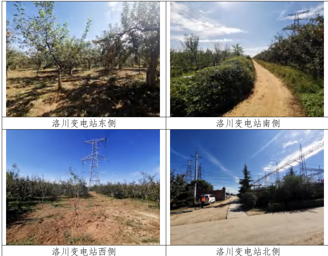
图4.1 洛川750kV变电站周围地形地情况
