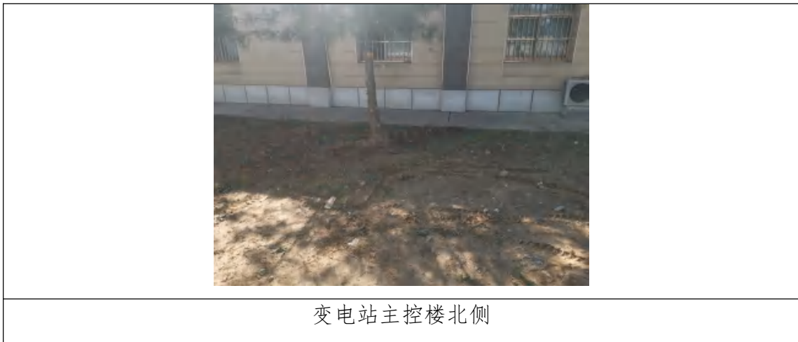
图3.6 洛川750kV变电站设置地埋式污水处理装置情况
