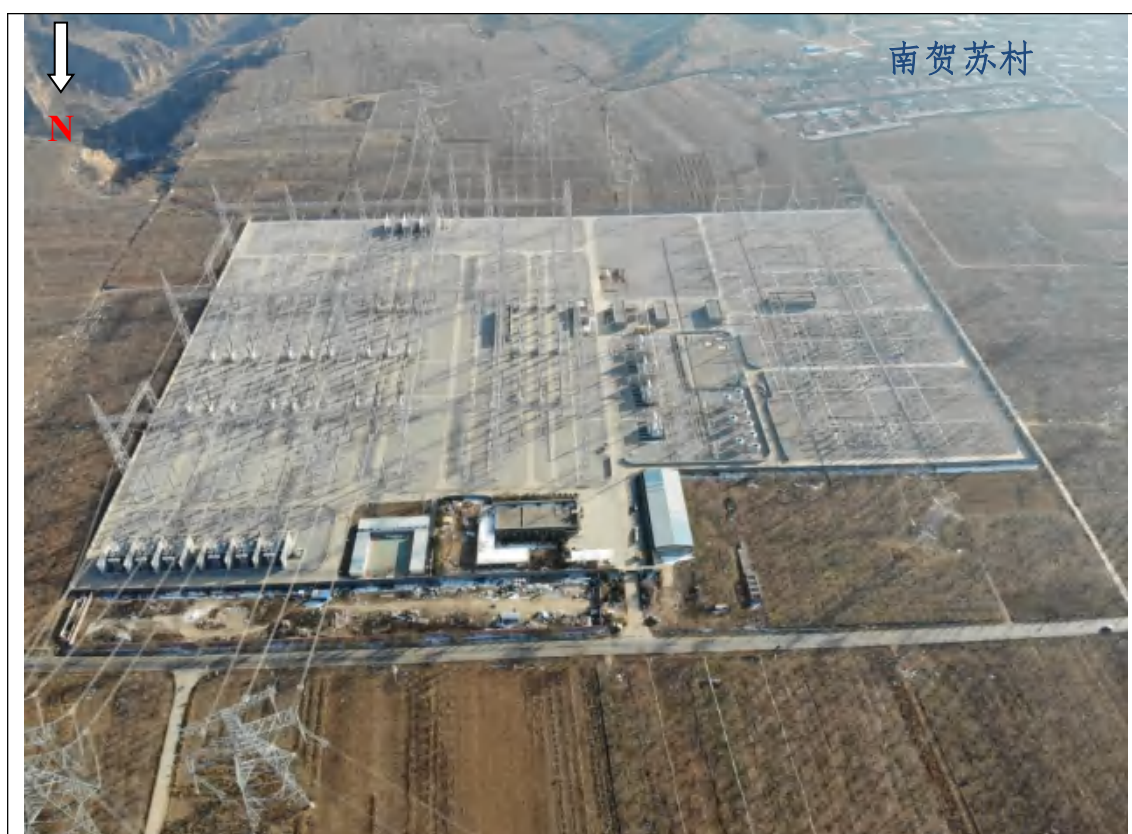
洛川750kV变电站俯视图
