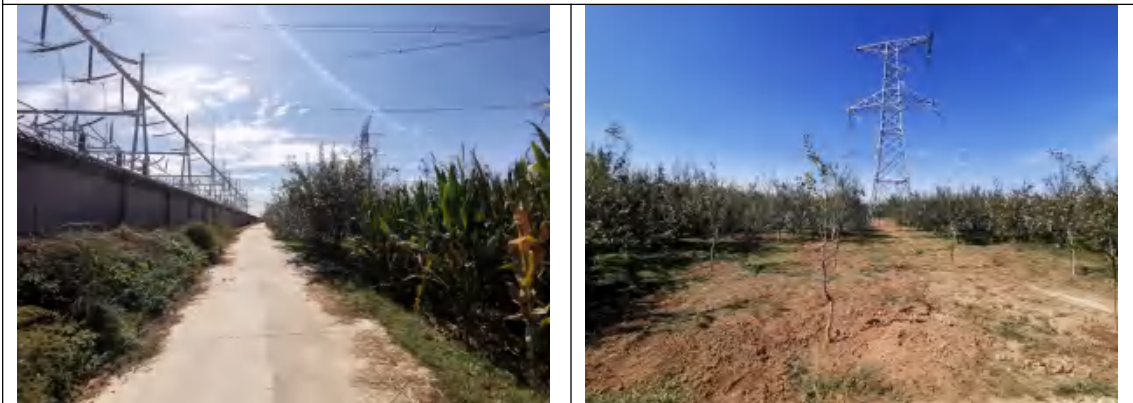
变电站西侧围墙外情况（周围为乡间道路、农田及苹果树）
