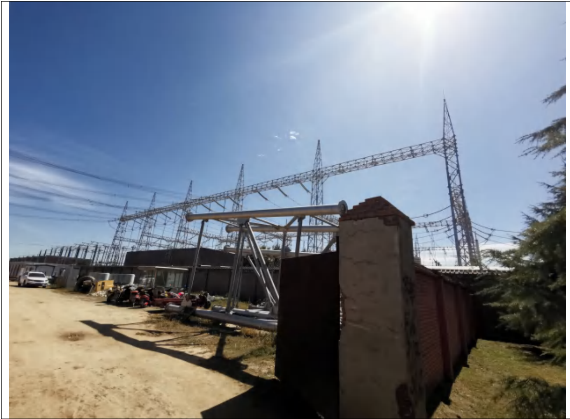
本期变电站扩建出线间隔处周围情况
