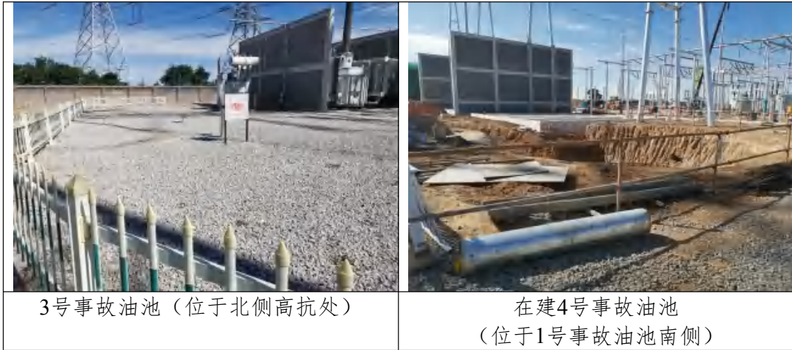
图3.5 洛川750kV变电站设置现有事故油池情况
