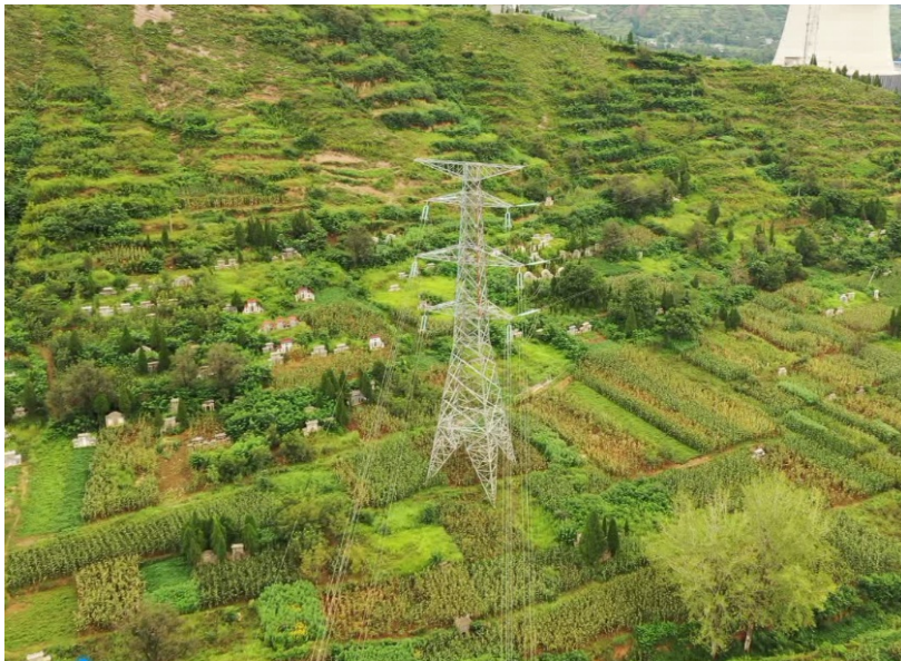
图 3 无人机监测塔基及临时施工场地土地整治
