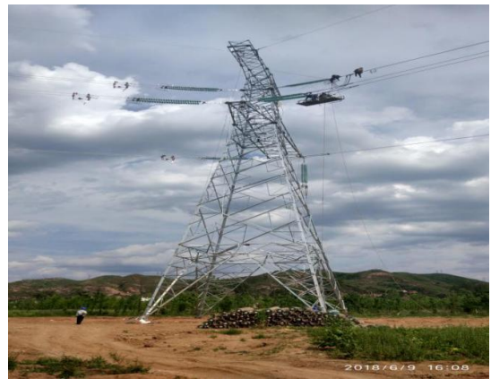
图 18 输电线路架线施工
