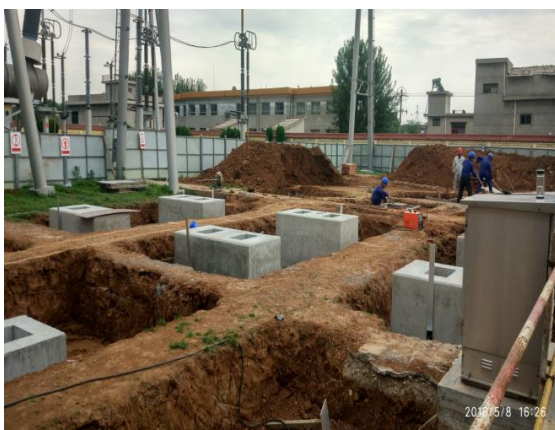
图 19 张村变电站间隔扩建基础施工
