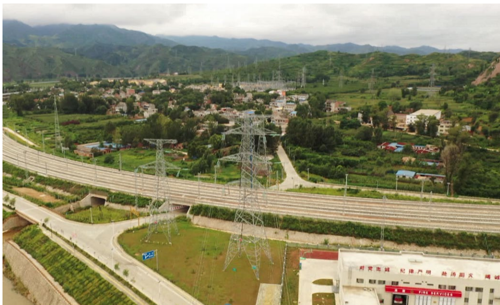
图 14 输电线路跨越铁路
