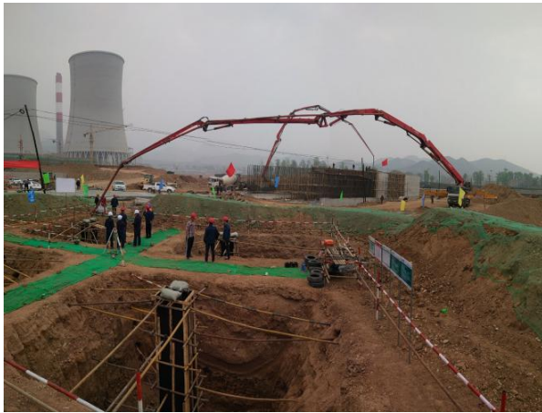
图 15 塔基基础施工临时苫盖
