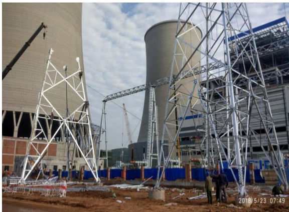
图 17 输电线路组塔施工
