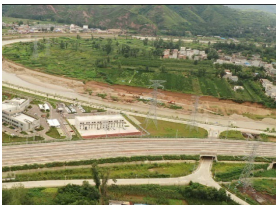
图 10 无人机监测塔基及施工场地绿化
