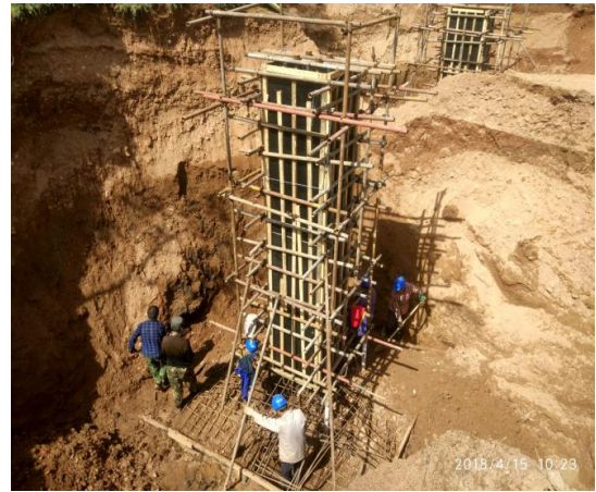
图 16 塔基基础施工
