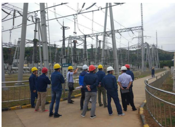
图 20 张村变电站扩建工程转序前监检
