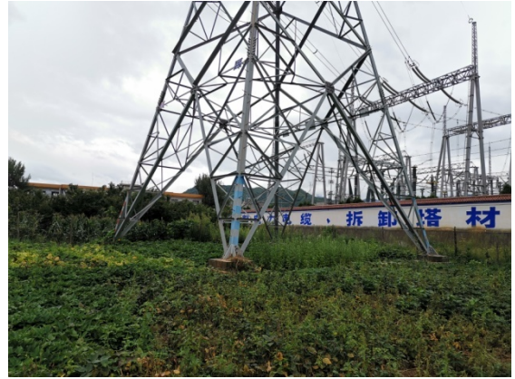
图 2 塔基临时施工场地复耕
