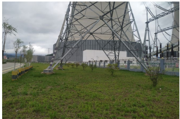
图 5 塔基临时施工场地绿化
