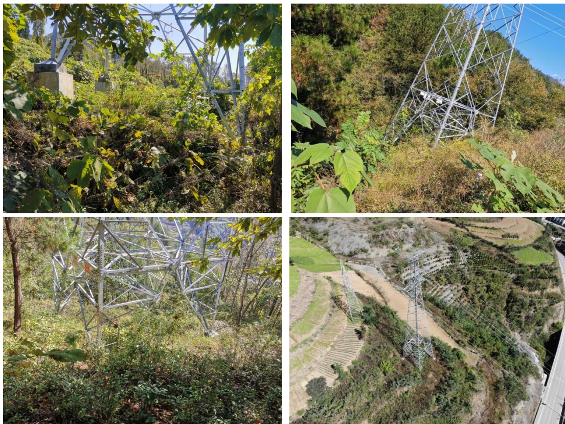
工程现场植被恢复
