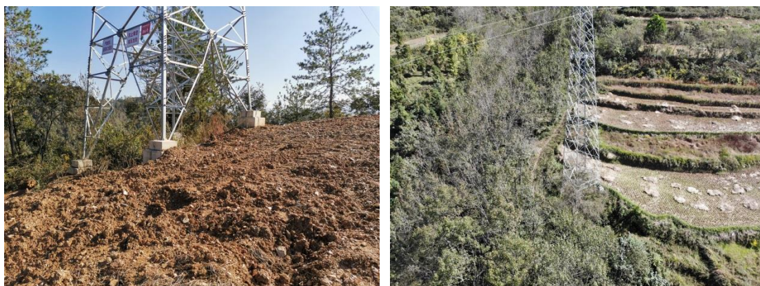
塔基施工场地复耕
