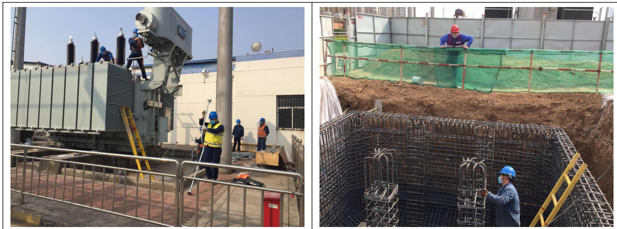
图 6-1 莲池 110kV 变电站施工期情况
