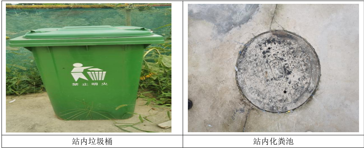
图 6-3 莲池 110kV 变电站环保设施情况
