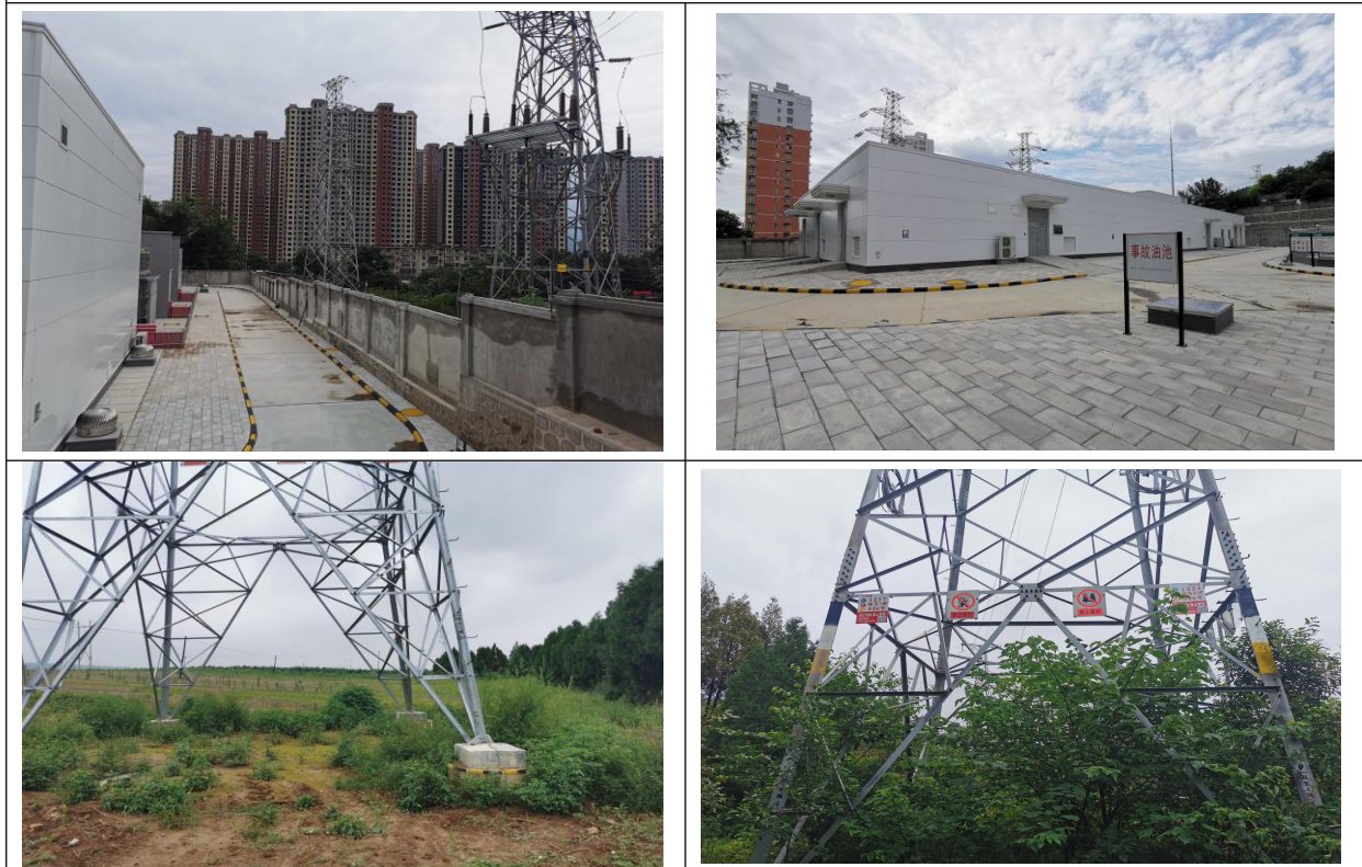
图 6-2 玉润 110kV 变电站及线路环境状况
