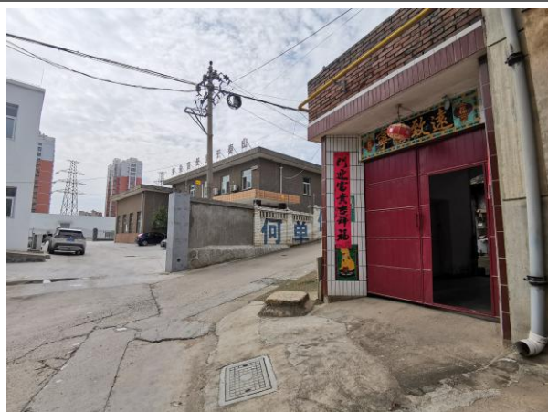
变电站东侧陈某家
