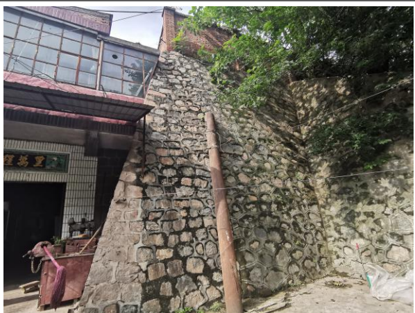
紧邻变电站西南侧陈某家
