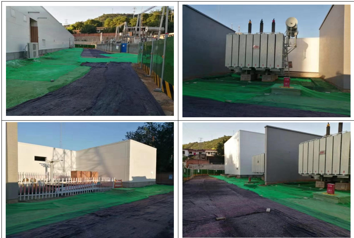
图 6-1 玉润 110kV 变电站施工期情况
