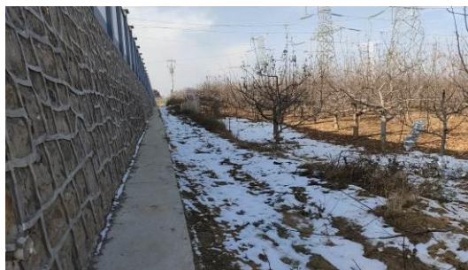
图 5.1-11 宜川 330kV 开关站厂界恢复情况 (3) 330kV 输电线路工程防治区
