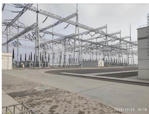
图 5.1-9 宜川 330kV 开关站道路硬化情况
