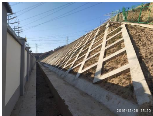
图 5.1-8 安塞 330kV 开关站站外排水沟及护坡
