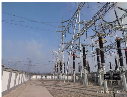
图 5.1-10 宜川 330kV 开关站碎石覆盖情况
