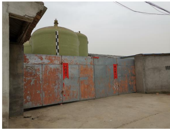
变电站北侧厂房
