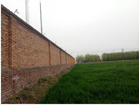
变电站围墙北侧
