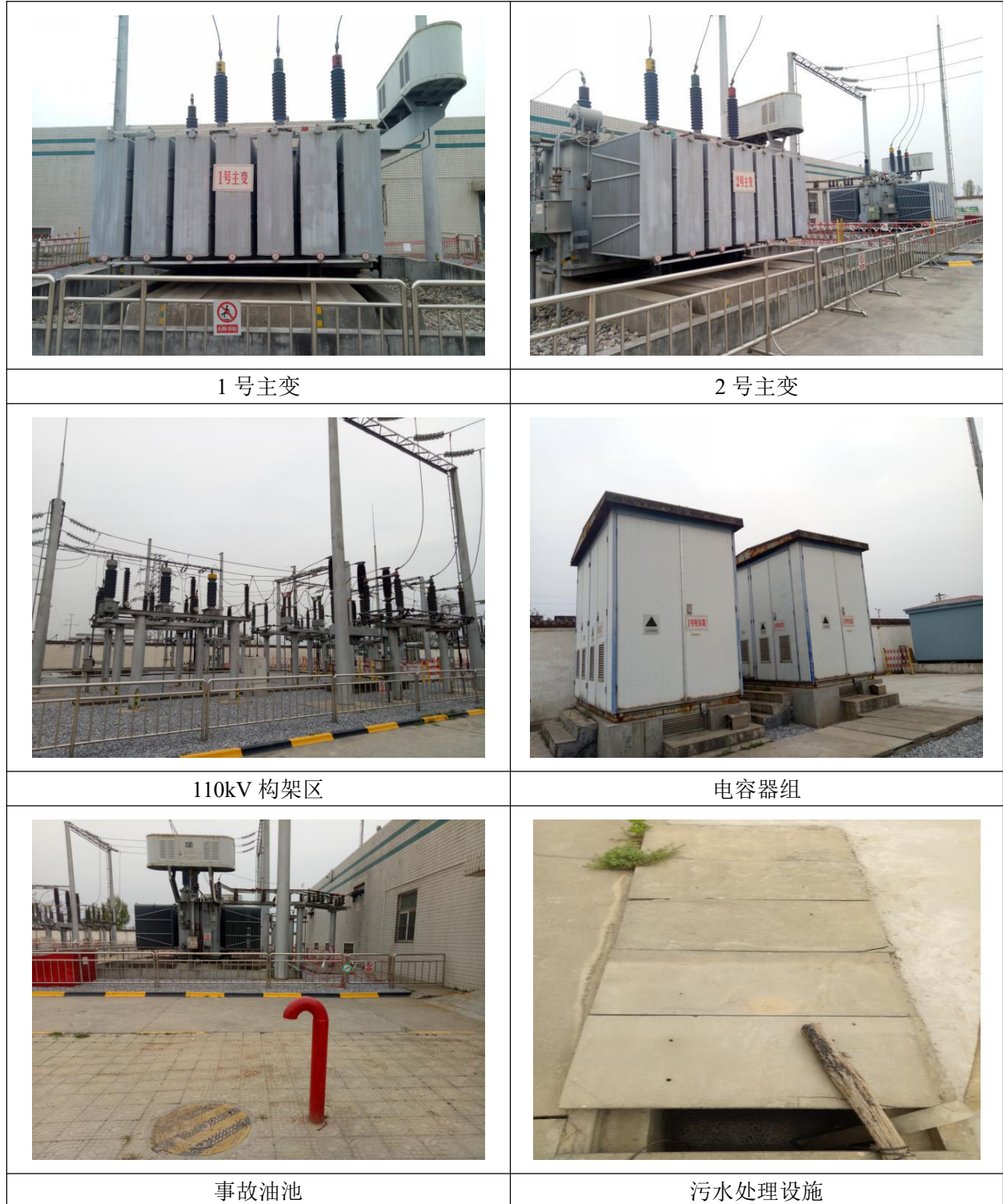
图 1-2 咏佳 110kV 变电站现状照片
