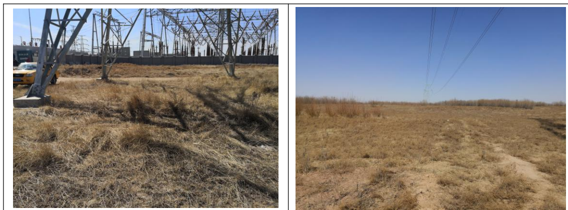
图 6.3-1 本工程线路沿线植被恢复情况
