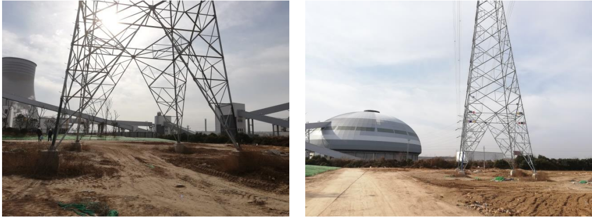
照片 8-1 G2#塔基及塔基施工区现状
