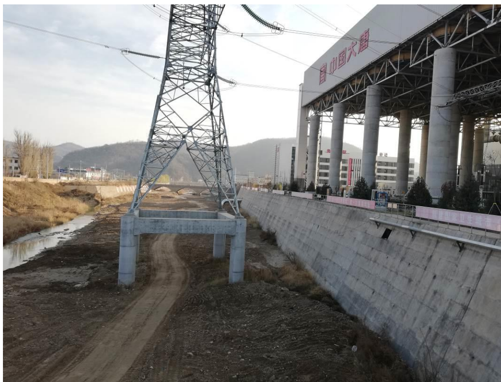
图 6.3-1 蟠龙河与延安~朱家 \pi 入大唐延安热电厂 330kV 线路位置关系图
