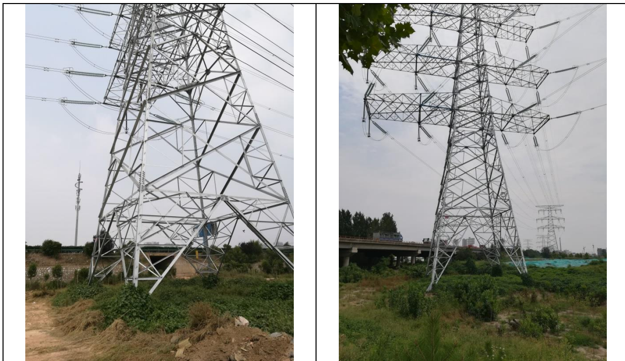
图 6.4-1 输电线路塔基绿化恢复照片
