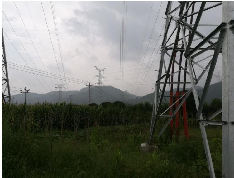
图 6-2 线路钻越 330kV 输电线路图
